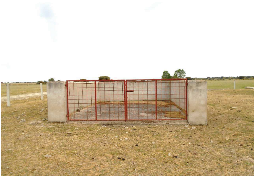
Descripción: Vista noroeste del estercolero de ovino existente.
