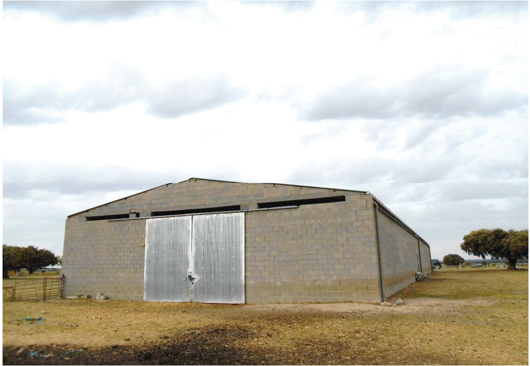
Descripción: Vista suroeste de la nave de ovino existente.
